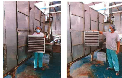
การใส่แผ่นฟิลเตอร์เพื่อดักจับฝุ่น และป้องกันเสียงดัง
